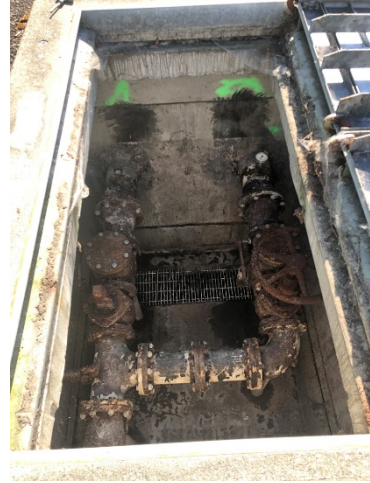
Liftstation #18: Original valve vault.
