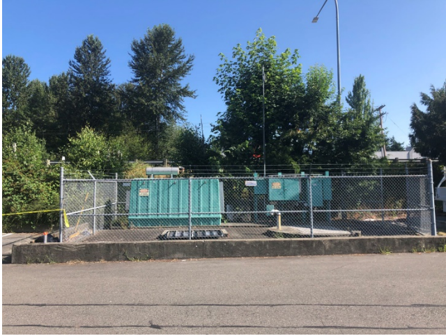
Liftstation #18: Original site.
